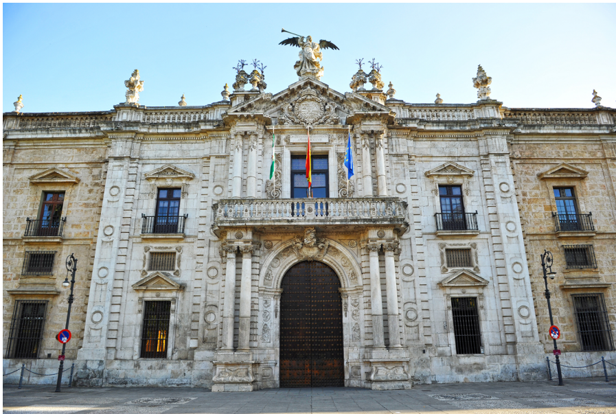
Figura 2: Fachada del edificio de la antigua Fábrica de Tabacos, Universidad de Sevilla.
